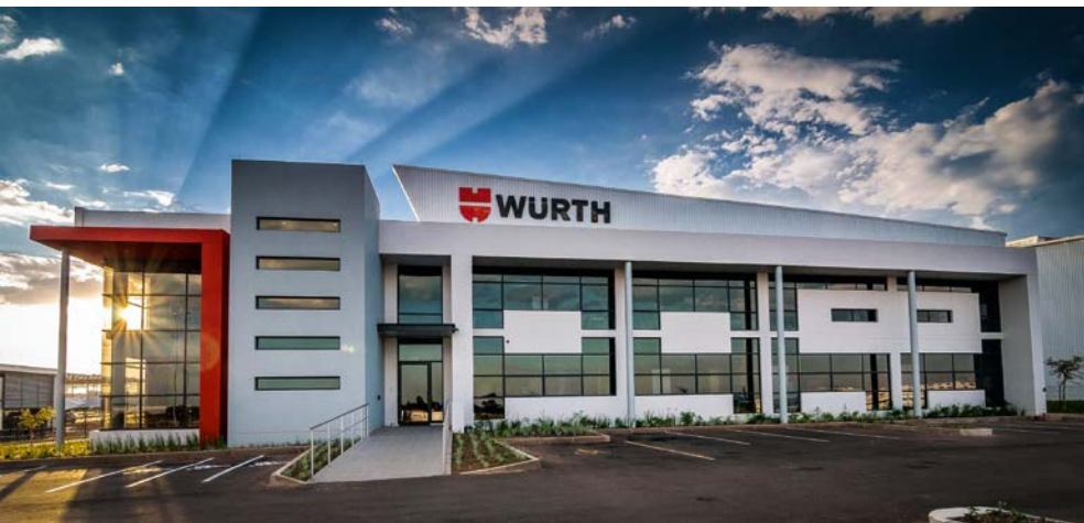
Wuerth South Africa (Pty.) Ltd. à Gauteng, Afrique du Sud
